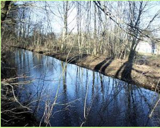
Der Fabrikkanal führt das Wasser aus dem Mühlteich Ridemands bis zum Hammerwerk. Das weisse Gebäude rechts ist die Mühle. Da die grösste Wasserdurchströmung der Hammerwerkturbine 524 Liter pro Sekunde ist, und die durchschnittliche Wasserführung im Bach *Guldbækken* nur 255 Liter pro Sekunde ist, ist das Mühlteich ein wichtiges Wasserreservoir gewesen.
